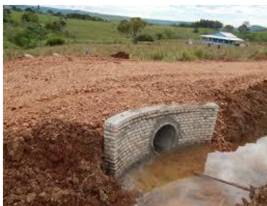
Figura 101 - Exemplos de dispositivos de drenagem corrente.
