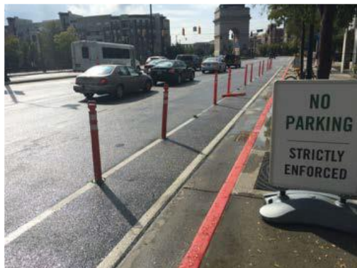
Figura 89 - Ciclovia temporária delimitada por balizadores.
