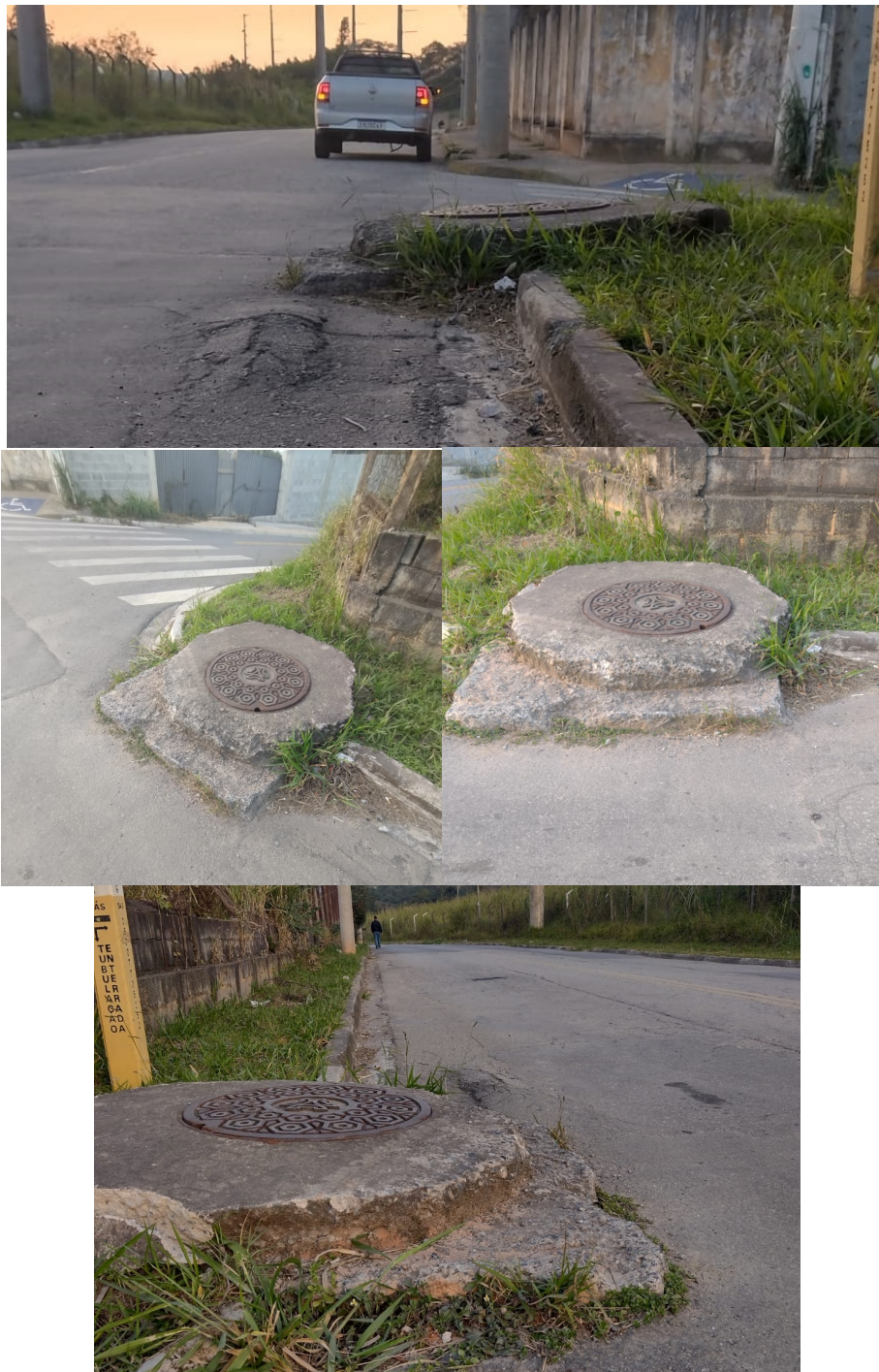
Fotos 1 a 4 : tampa de galeria subterrânea localizada na Estrada Imperial, esquina com Rua Sueli, sentido centro/bairro, fora dos padrões.
